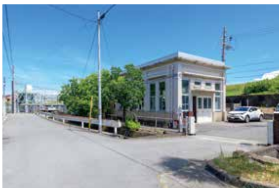
米新ポンプ場
