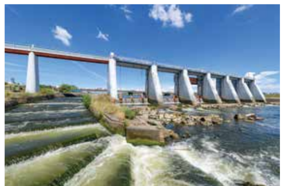
高砂取水場（加古川堰堤）
