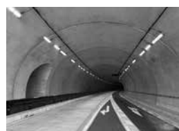
トンネル完成後坑内状況
