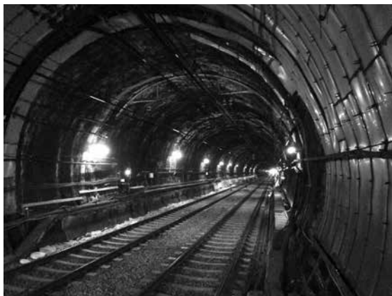
■大阪難波～近鉄日本橋間のシールドトンネル
