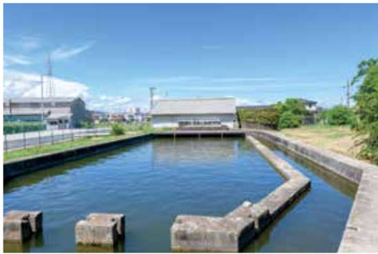
古新水源地（取水施設）
