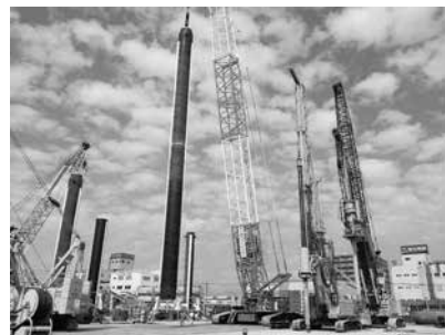
【鋼管矢板建込工法施工状況】
