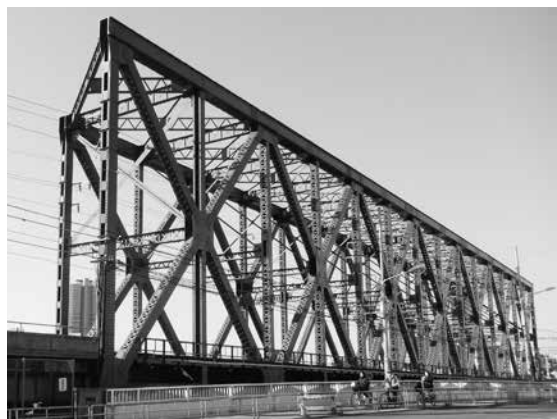
■大阪環状線にある木津川橋りょう(上)と岩崎運河橋りょう(下)
