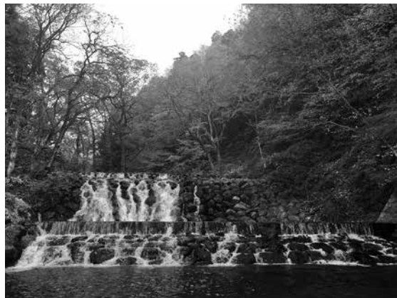
■鬼谷川砂防堰堤(正面)
