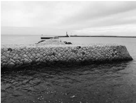
■一文字波止 (初代工楽松右衛門による築造 その後改修されたものと推定)
