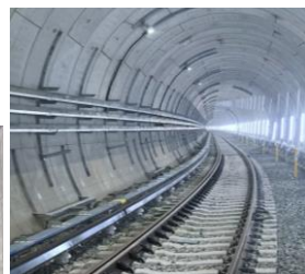
シールドトンネル区間完成写真
