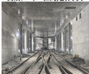
開削トンネル区間完成写真
