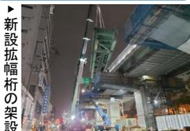
都市高速道路供用下という制約条件の多い中、無事に桁の架替えを完了し、縦目地構造を解消した。特に高速上の車線規制は社会的影響も大きく、工事渋滞も増加していた。1日も早い規制解放が求められる中、工程短縮に努め、当初の予定よりも規制設置期間を約4か月短縮した。
