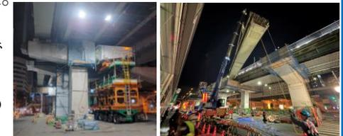
▲多軸台車による梁架設 ▲既設拡幅桁の撤去
