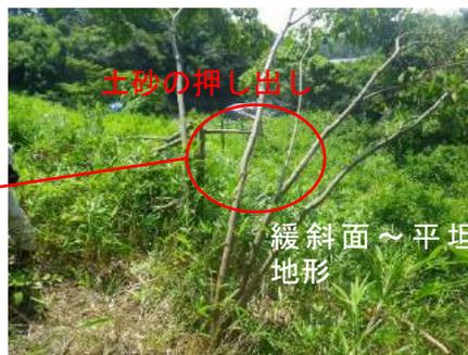
斜面の段差クラック近傍に、倒木の後を確認。
