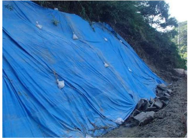
写真-2.3 崩壊箇所の養生状況
