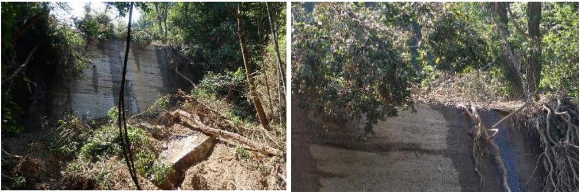
写真①-4：沢の中腹に設置された砂防ダムおよび土砂堆積状況
