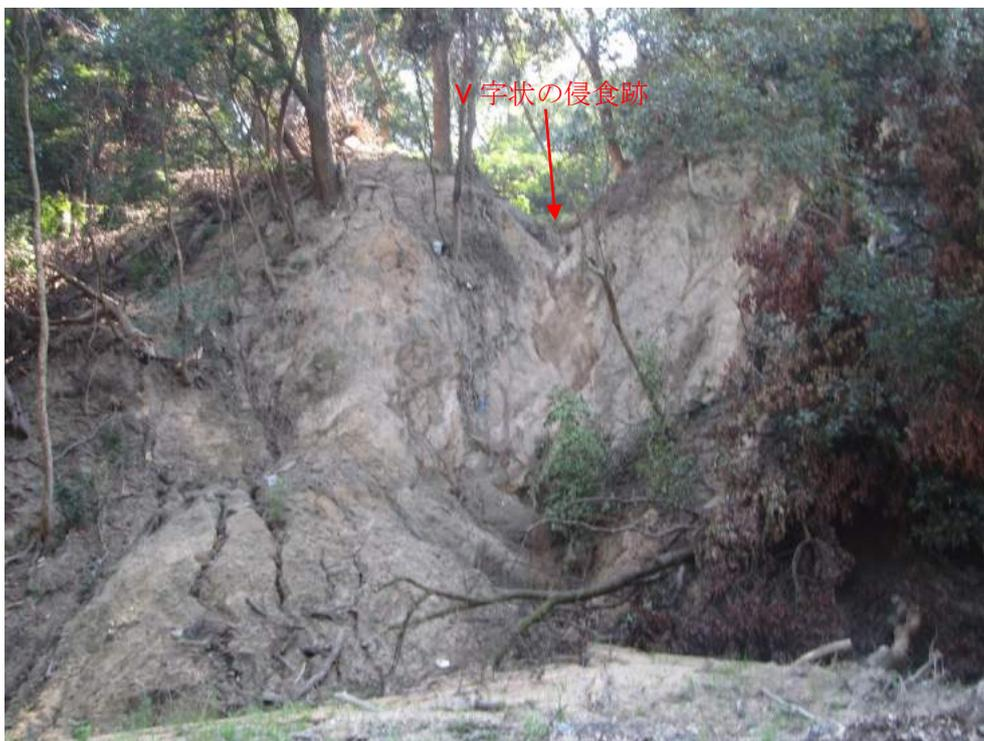
図-13 崩壊・土砂流出箇所の状況
