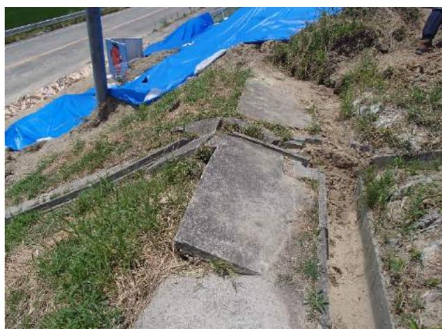
写真-3.5 排水工の変状状況
