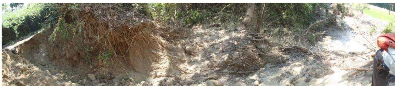
写真-6.2 ため池堤体崩壊箇所と崩壊土砂の流出状況
