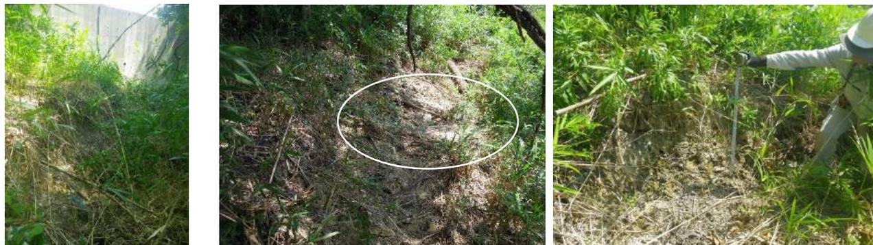
擁壁直下の斜面に見られる段差クラック。擁壁部のクラックと連続している可能性が高い。
