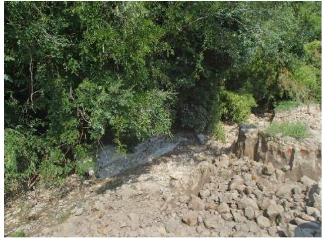
写真-8.2 前面に倒壊した被災護岸の状況
