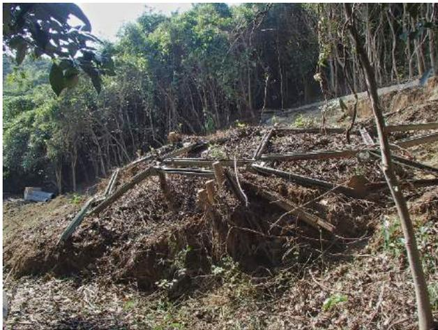
写真-1.4 崩壊した軽量法柱
