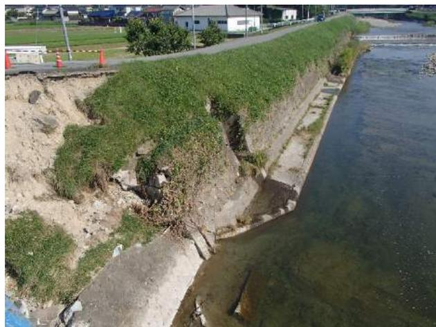
写真-9.6 上流側護岸と根固め工
