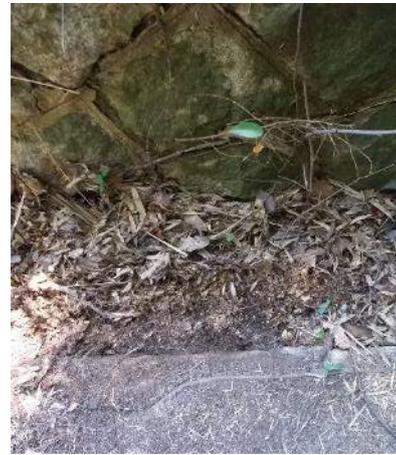
写真-2.7 崩壊斜面頂部の既設側溝
