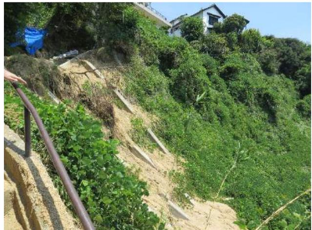
写真-1.6 崩壊箇所下部の対策工の状況
