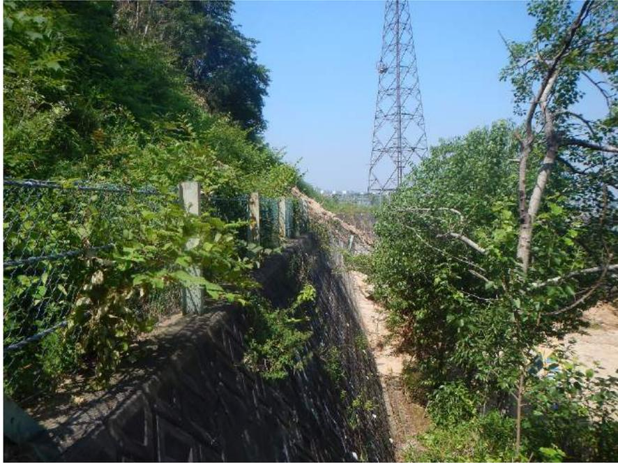
図 6 ブロック積擁壁ならびに落石防護柵の状況
