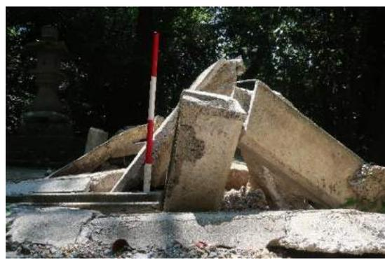
写真④- 4 : 大きく変形・損傷した階段
