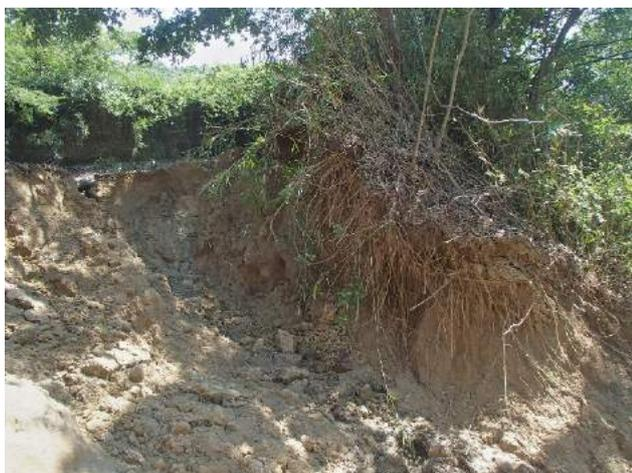
写真-6.8 堤体崩壊箇所の左岸側の状況
