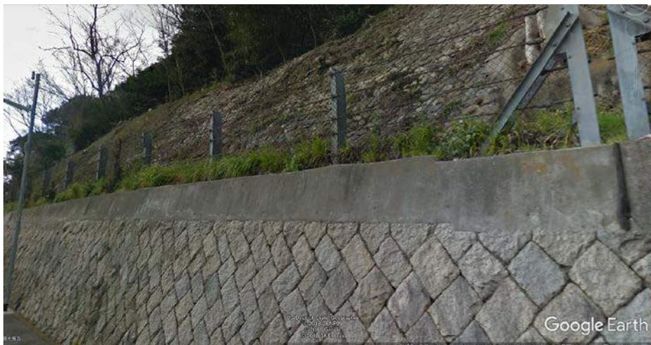
図-11 崩壊前の斜面の様子 (Google Earth より抜粋、石張り工が中腹までなされている)
