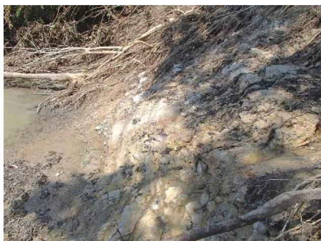
写真-6.7 崩壊した堤体直下の露頭
