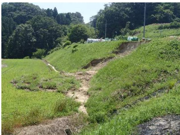
写真-4.3 圃場整備によるのり面崩壊状況
