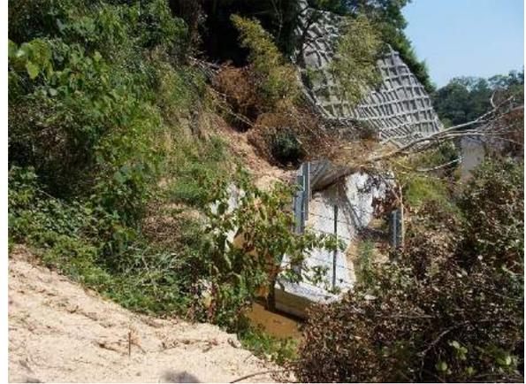
写真-2.5 待受け式擁壁背面の状況
