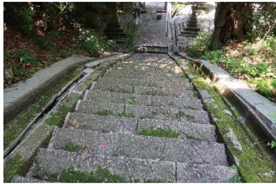
写真④- 3 : 地すべり変動により隆起した階段
