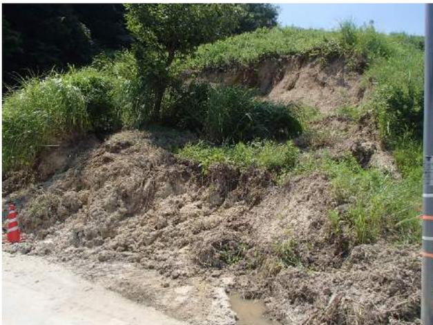
写真-4.1 道路盛土のり面の崩壊状況
