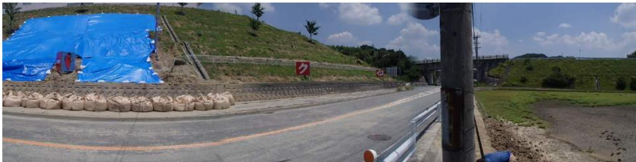
写真-3.1 崩壊箇所と土砂流出範囲の状況
