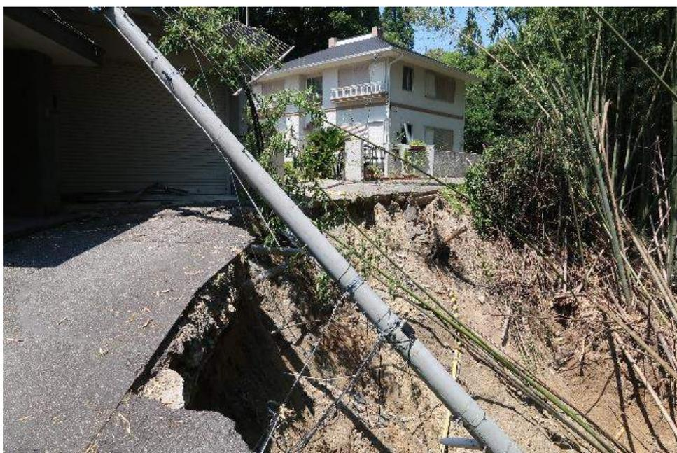
写真③-1：崩壊した斜面および倒れた電柱
