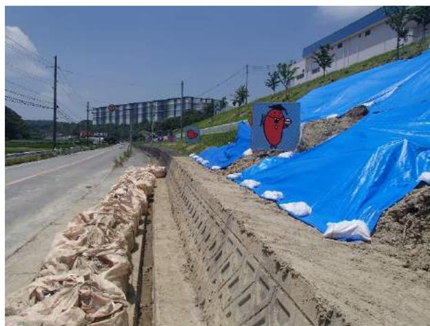
写真-3.4 看板による土砂堰止め状況
