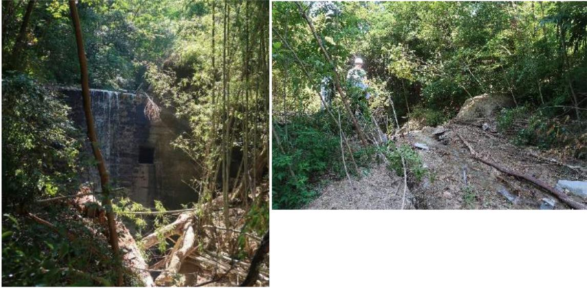
写真①-3：沢の出口付近で設置された砂防ダムおよび貯砂池における土砂堆積状況
